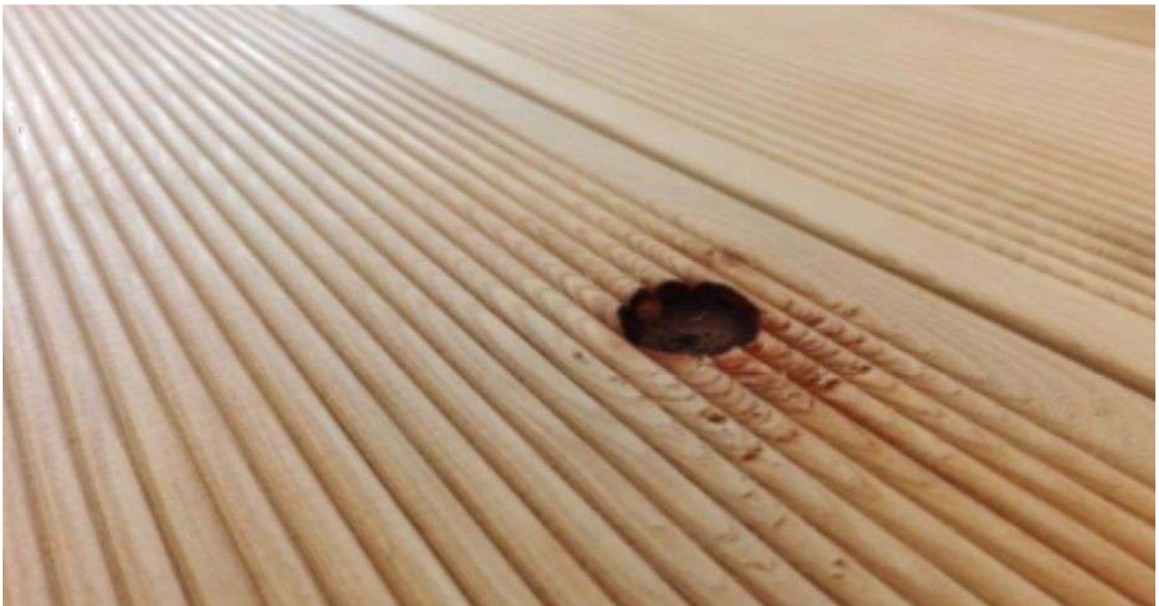
Foto 25 – ein ausgefallener Ast auf der Oberfläche der Holzdielen
