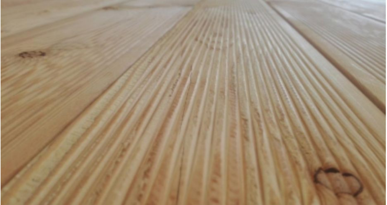
Foto 21 – ein kerniger Teil mit Verfärbung
